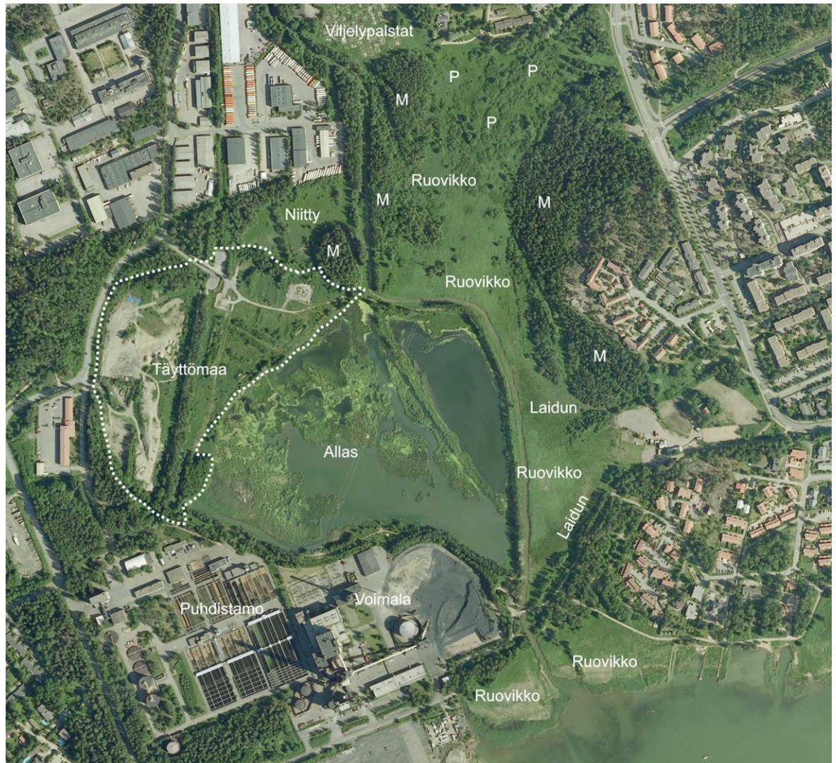
Kuva 2. Suomenojan alue. Allas erottuu puustoisten reunapenkereidensä ansiosta. Täyttömaa on rajattu katkoviivalla. Täyttömaan läpi pohjoiseen kulkee kaukolämpöputkia, joiden varrella on lehtipuustoa. Altaan itä- ja pohjoispuolella on luonnontilaisempaa säilynyttä merenlahtea. Kosteikon reunametsät on merkitty kuvaan M-kirjaimella ja pensoitunut kosteikko P-kirjaimella. Ilmakuva on vuodelta 2005.
